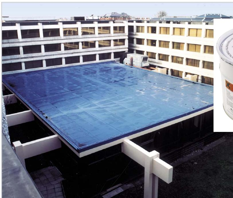
Pro zajištění střešní fólie proti pronikání větru a zvedání střešního pláště se často používá tato varianta, pokud to vyžadují místní povětrnostní podmínky či jiné zvláštnosti střešní konstrukce.
