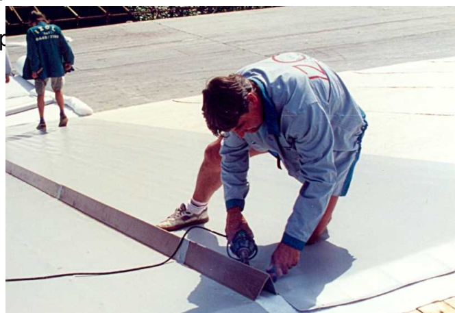
Jednatel společnosti IZOLPROTAN s.r.o. při realizaci fóliového systému v roce 1992.
